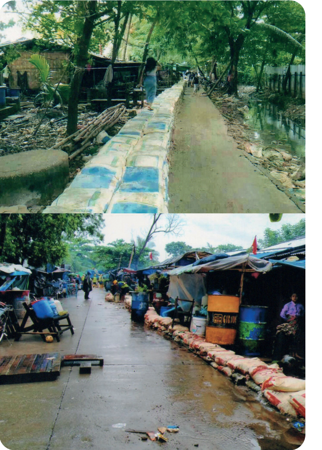
မြောက်ဥက္ကလာပနှင့်တောင်အာရှမြို့နယ်များတွင် သဲအိတ်များဖြင့် ရေလွှမ်းမိုးမှုကို ကာကွယ်ခြင်း ဓာတ်ပုံ - ရေစီးရေလာနှင့်ရေဆိုး စီမံခန့်ခွဲမှုဌာန
